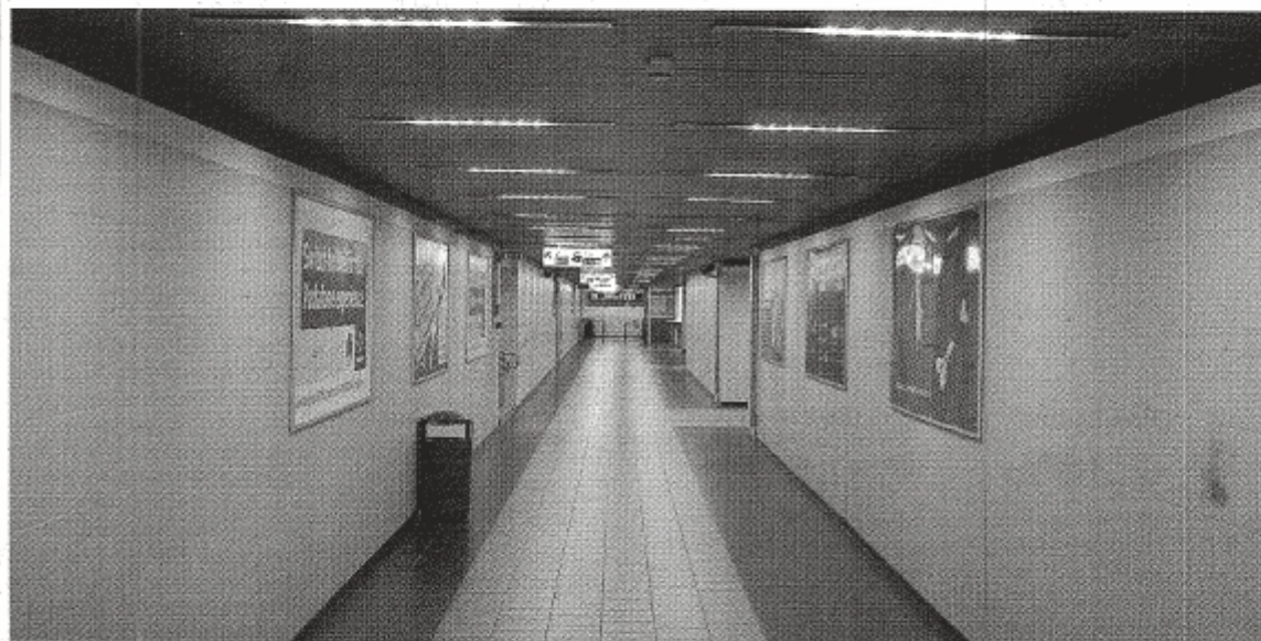
► LED ŠVIESTUVAI Vilniaus geležinkelio stotyje padėjo 3 kartus sumažinti tunelio ir 7 kartus – informacinių švieslenčių apšvietimo sąnaudas. Stotyje LED šviestuvų yra ir daugiau. HERKAUS MILAŠEVIČIAUS NUOTR.
